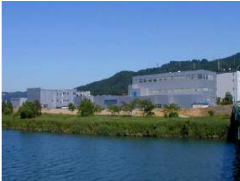
(株)オプテス高岡工場 2002年10月上市 (2001年12月竣工)
